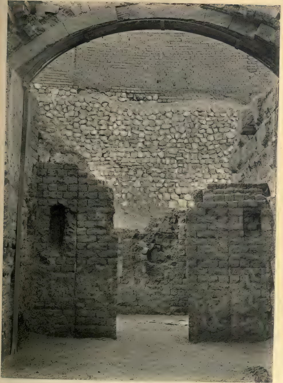
Le couloir copte après la restauration.
